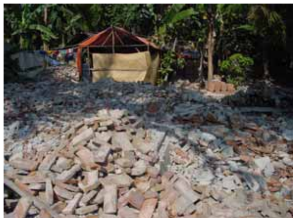
写真 - 5 建物被害の様子(レンガ造(RC柱無))
