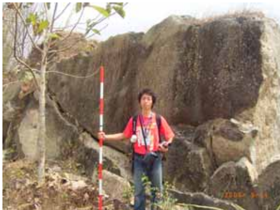
c) 斜面上部の岩塊の亀裂
