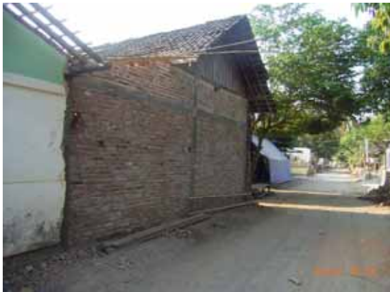
写真 - 2 レンガ(Bata)造の家(RC柱有)
