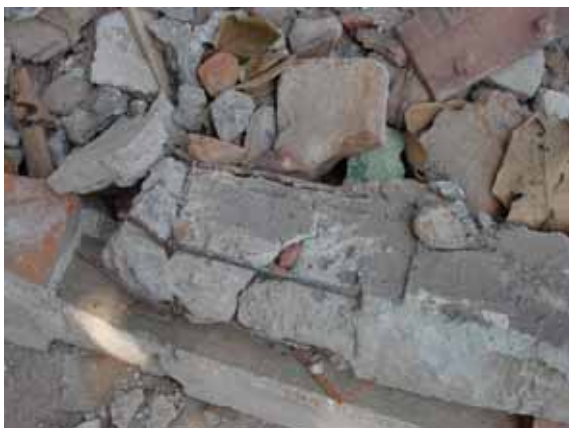
写真 - 4 RC柱の様子
