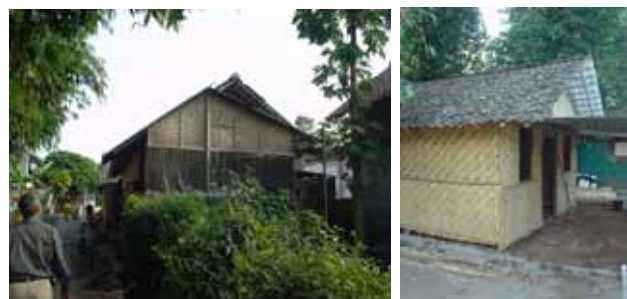
写真 30、31 竹の仮設住宅の例
