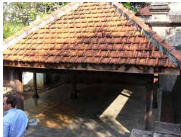
図 - 6 入口門に西側隣接の小屋被害
