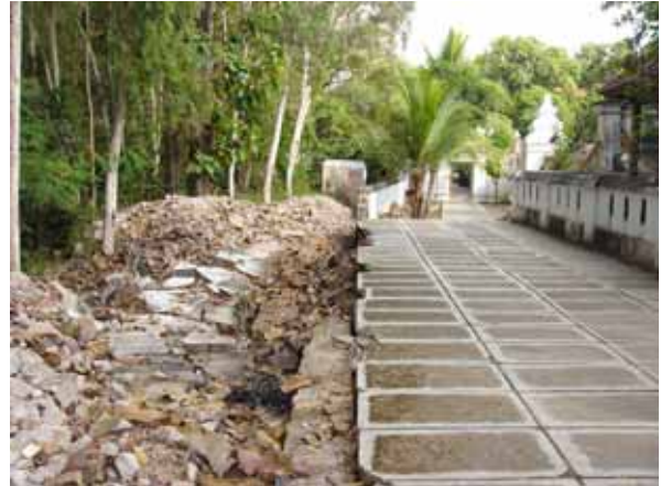
図 - 11 墓石中央より西側の状況
