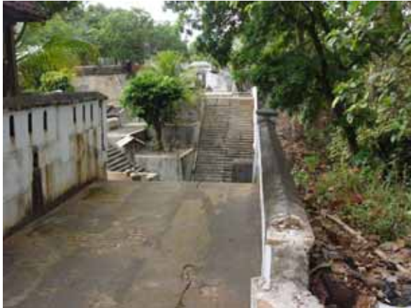
図 - 10 墓石中央部の階段部を望む
