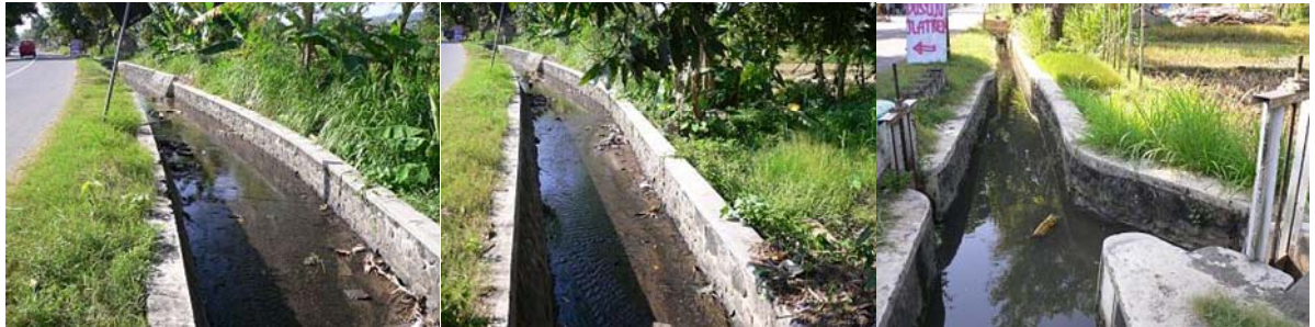
(b) 道路脇の灌漑用水路の様子
