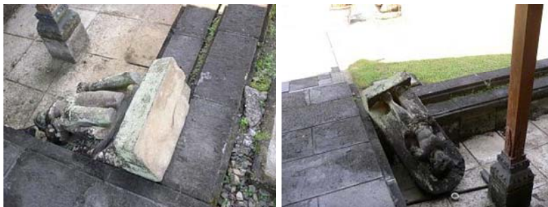
写真-18 倒れた石像（Prambanan）
