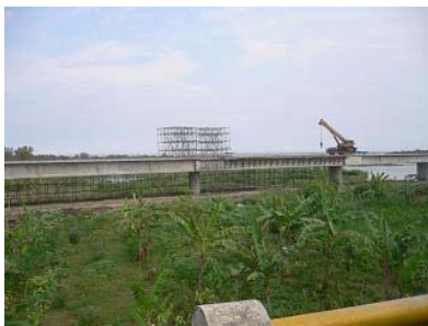
写真-14 Progo 川に建設中の橋梁
