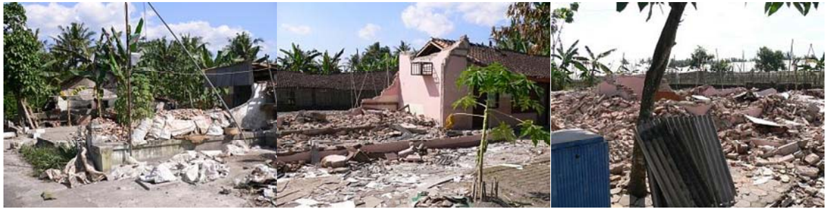
写真-20 ほぼ壊滅した集落の様子（Gantiwarno）
