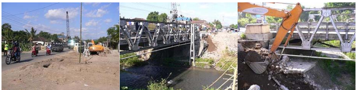
写真-22 橋台の修復現場
