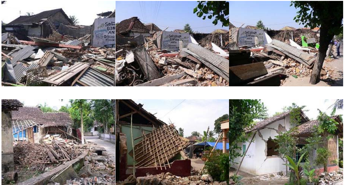
写真-5 Bantul 市街地の建物の倒壊
