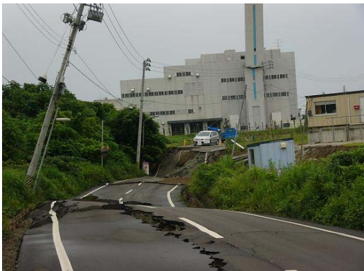
図3：柏崎市橋場町 道路陥没
