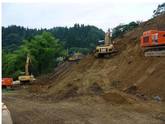
図1：長岡市大積千本町 斜面崩壊
