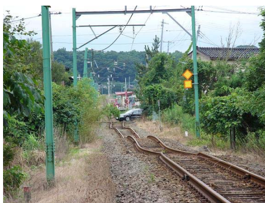
図6：J R越後線荒浜駅 レール変状
