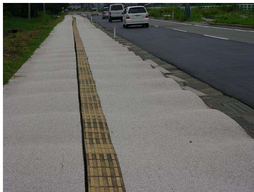
図4：県道73号線鯨波宮川線 道路変状
