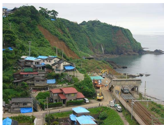
図2：J R信越本線青海川駅 斜面崩壊
